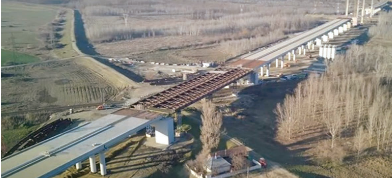
STRUCTURĂ CU DOUĂ PODURI ȘI DOUĂ VIADUCTE ● SIRET
